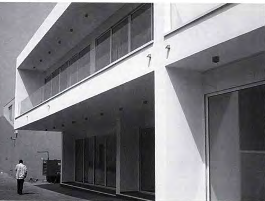
Aspecto general de la fachada principal de la Embajada de Colombia en Accra, Ghana. Foto: Cortesía Pedro A. Roa.
